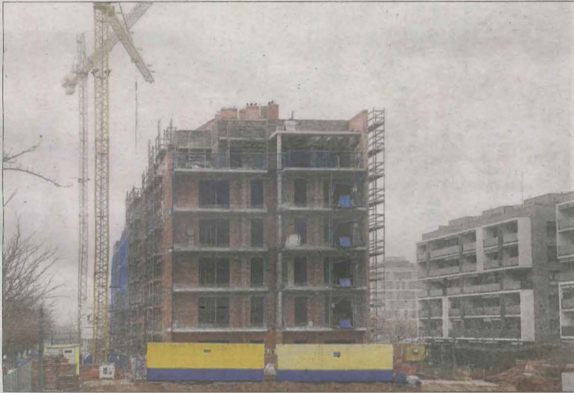
Pisos en construcció en una imatge del mes passat.
