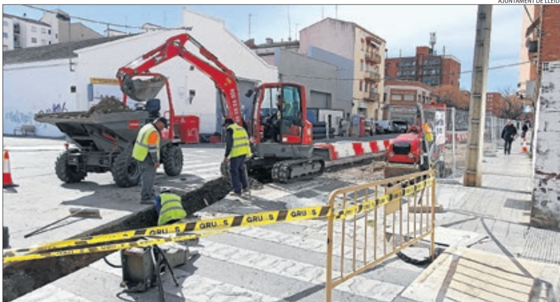
El tall de trànsit és per ampliar voreres i fer passos elevats a Anastasi Pinós i Jeroni Pujades.
