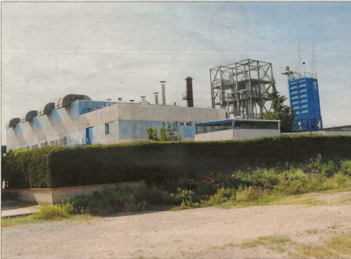
Les instal·lacions actuals de la planta d'assecatge de purins de Tracjusa a Juneda.
