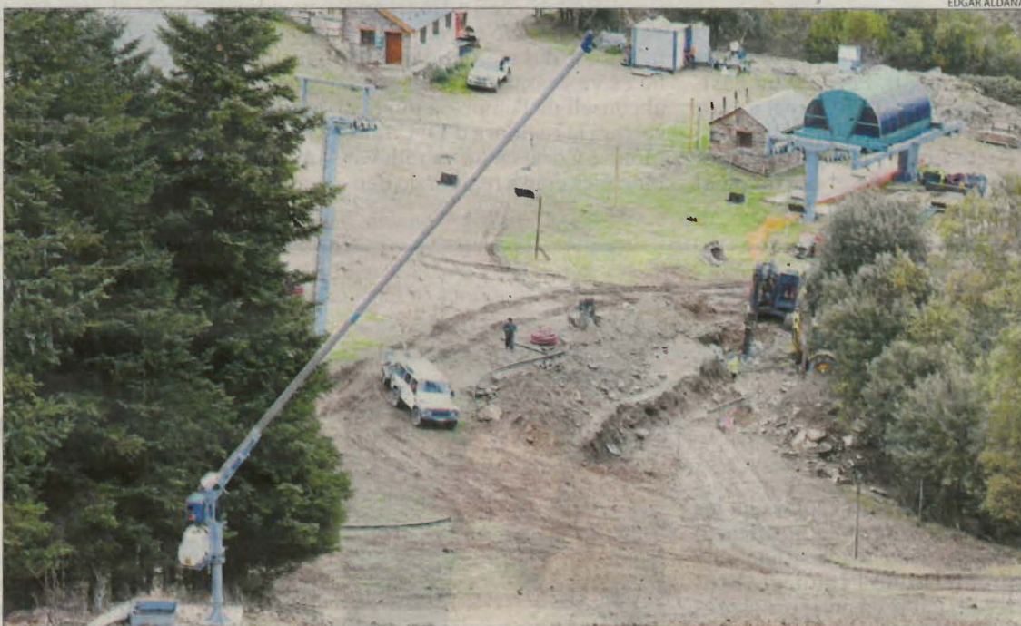
Vista de les obres del nou sistema d'innivació a la base de l'estació de Tavascan.
