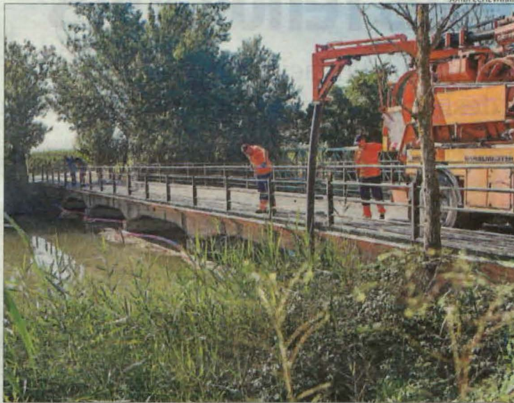
Els treballs per aturar l'abocament a Utxesa el 2021.
