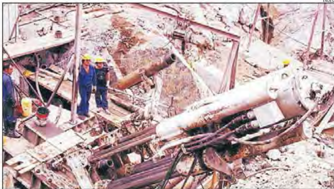
La construcció de la central reversible va incloure el 1985 el rècord de bombatge de formigó en altura.
