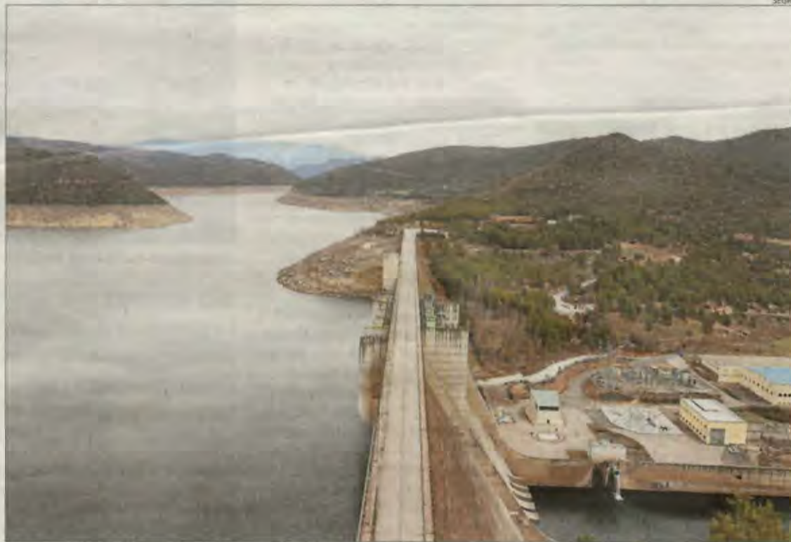
Una de les centrals venudes al gegant japonès és la que està a peu de la presa a Rialb.
